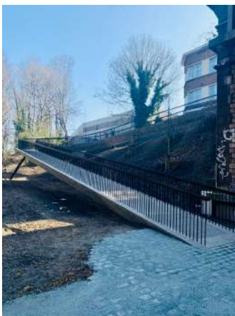
bouw van een voetgangers- en fietsbrug, Brussel ontwerp: BAUKUNST
