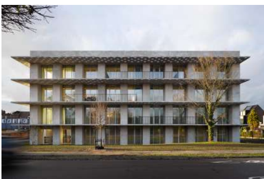
verbouwing van een kantoorgebouw, Kortrijk ontwerp: OFFICE Kersten Geers David Van Severen
